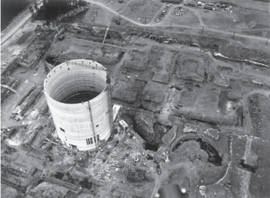
Kuva 1.1 Loviisan ydinvoimalaitoksen työmaa toukokuussa 1972
