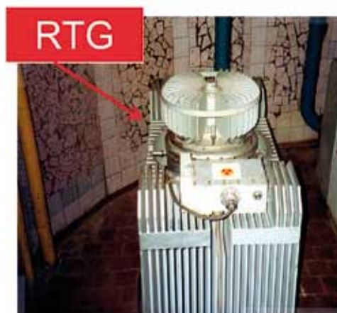
Miesten löytämät lieriöt olivat termosähköisten generaattorien (RTG) voimanlähteitä.
