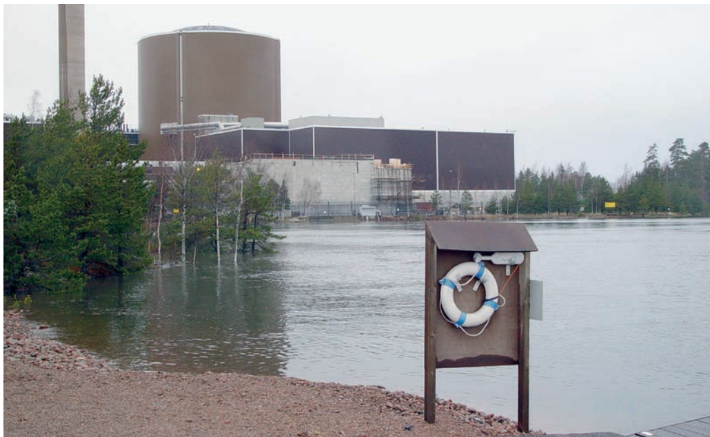
Korkea vesi ei uhannut Loviisan ydinvoimalaitoksen turvallisuutta, mutta uhkasi ajaa sen seisokkiin.
