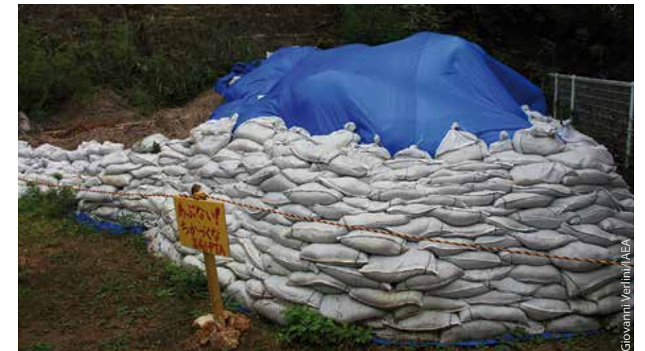
Saastuneelta alueelta kerättyä jätettä säilytetään vesitiiviissä säkeissä.
