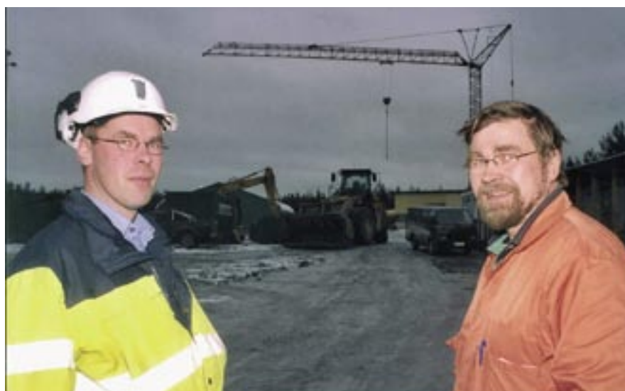
Onkalotyömaa etenee hyvää vauhtia, kertovat työnjohtaja Pentti Tarvainen Kalliorakennuksesta ja rakennusvalvoja Rami Rintanen Posivalta.
