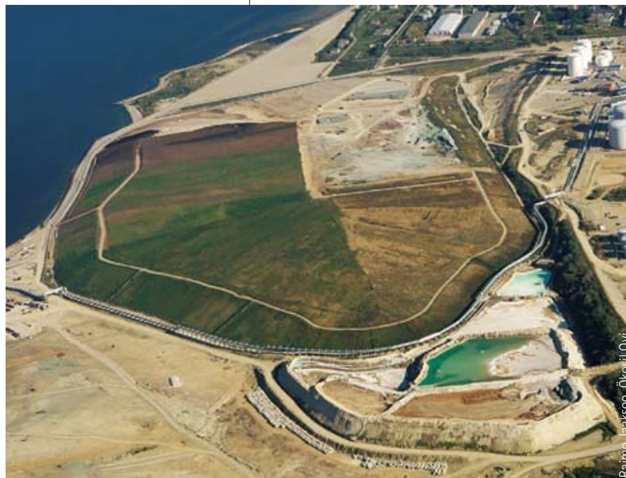
Sillamäen jätealue vuonna 2007. Alueen edustalle on rakennettu uusi Sillamäen satama, jonka edellyttämä merialueen täyttö näkyy kuvan alaosassa.
